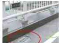
橋の劣化に直接関係する部材で、ここが詰まっていると橋面上に水が溜まり、橋の劣化につながる
