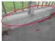
高欄の基礎となる部材で、排水柵を設置する部材でもある
